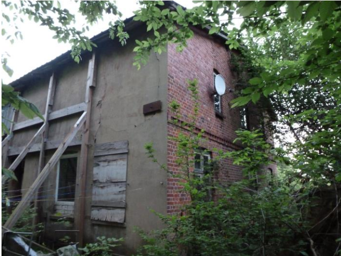
O.Grell. 09.05.18. Teilansicht Plangebiet, abgängiges Gebäude
