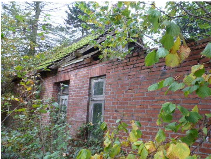
O.Grell. 31.10.17. Teilansicht Plangebiet, abgängiges Gebäude
