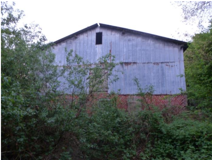
O.Grell. 09.05.18. Teilansicht Plangebiet, abgängiges Gebäude
