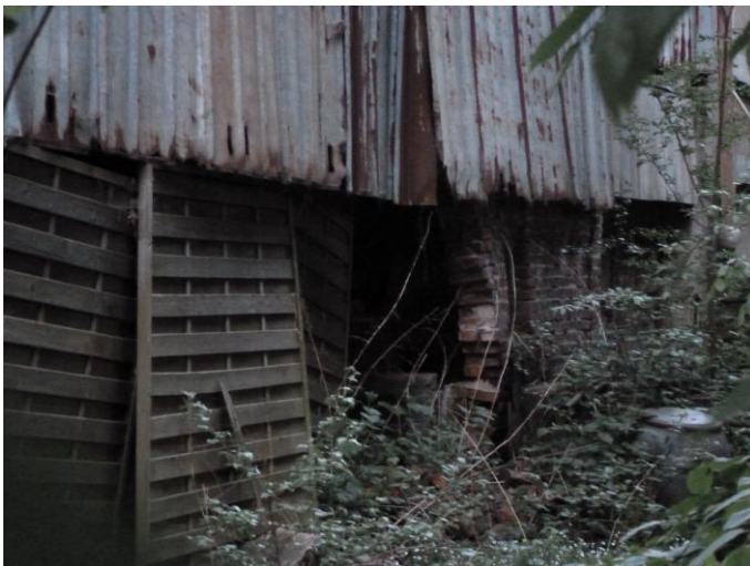
O.Grell. 09.05.18. Teilansicht Plangebiet, abgängiges Gebäude
