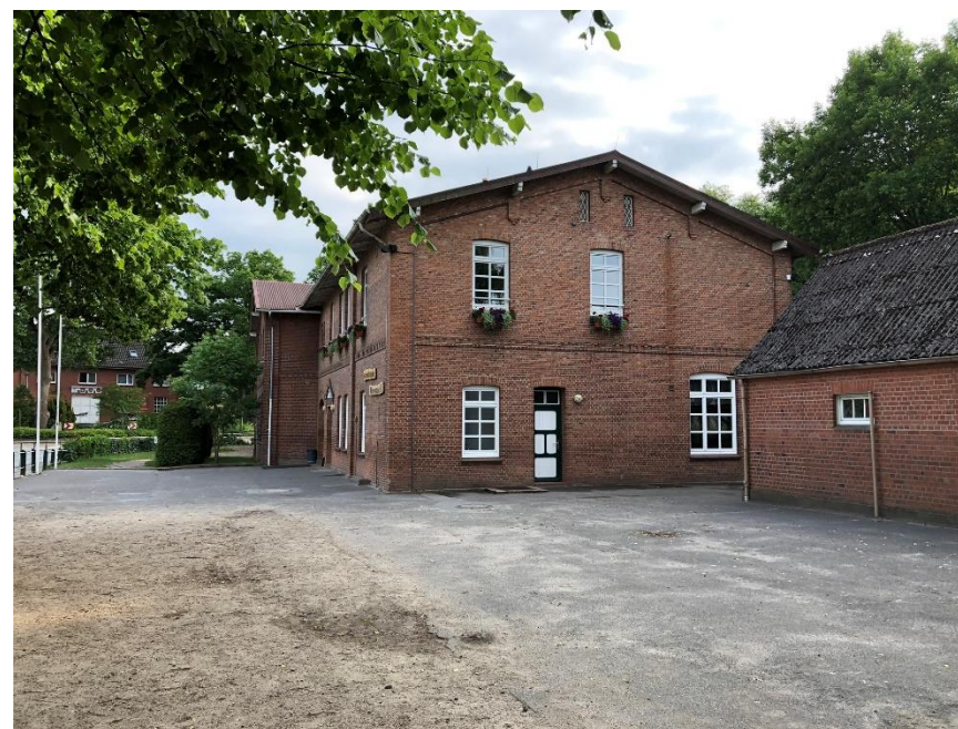
Abbildung 20: Blick auf die Grundschule (CIMA 2022)
