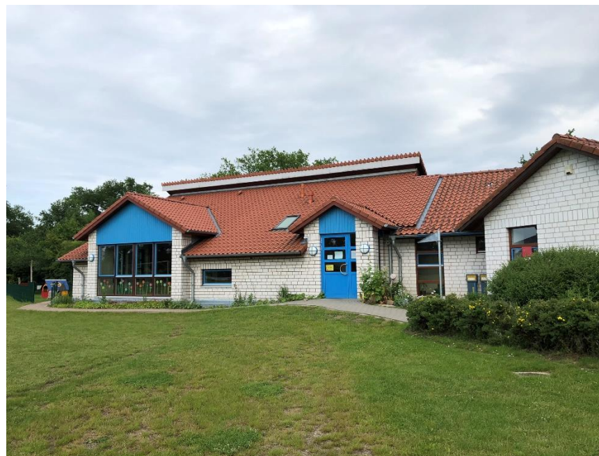
Abbildung 18: Der Kindergarten in Wakendorf II (CIMA 2022)
