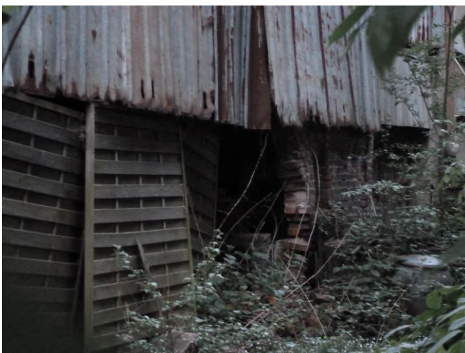
O.Grell. 09.05.18. Teilansicht Plangebiet, abgängiges Gebäude
