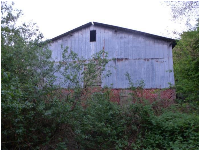
O.Grell. 09.05.18. Teilansicht Plangebiet, abgängiges Gebäude
