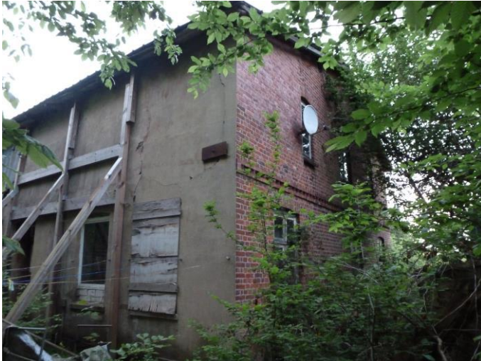
O.Grell. 09.05.18. Teilansicht Plangebiet, abgängiges Gebäude
