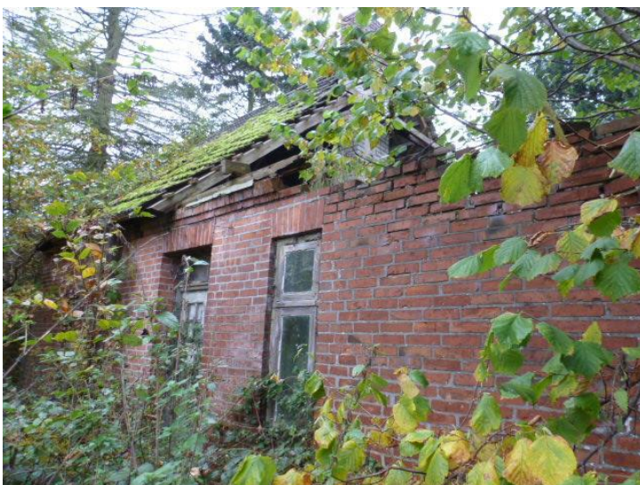
O.Grell. 31.10.17. Teilansicht Plangebiet, abgängiges Gebäude
