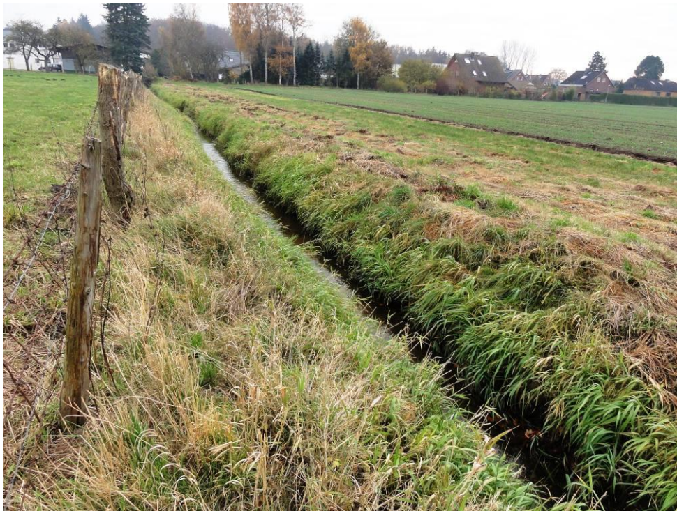
Abbildung 9: Wasserlauf Rendsbek. Blickrichtung Südosten
