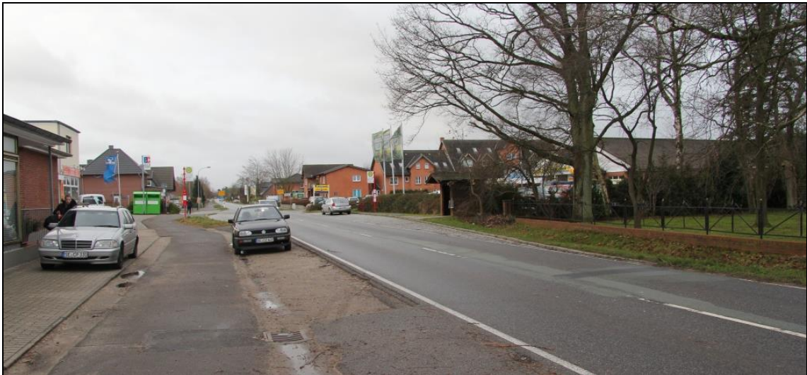
Kalte Weide (L 78), Blick von Nordosten nach Südwesten
